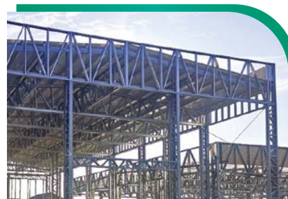
Bâtiments industriels Bâtiments délevages, entrepôts commerciaux ...
